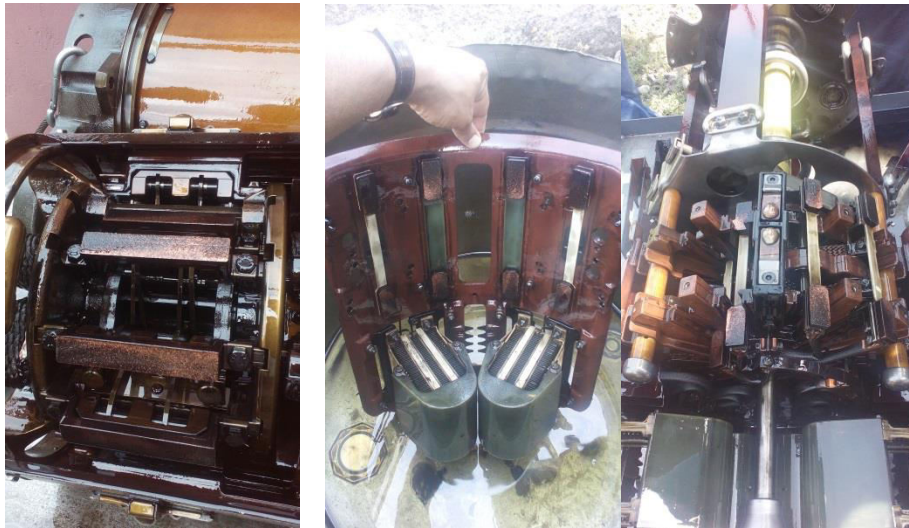
Slika 4 – Prikaz kontakata regulacionih sklopki
